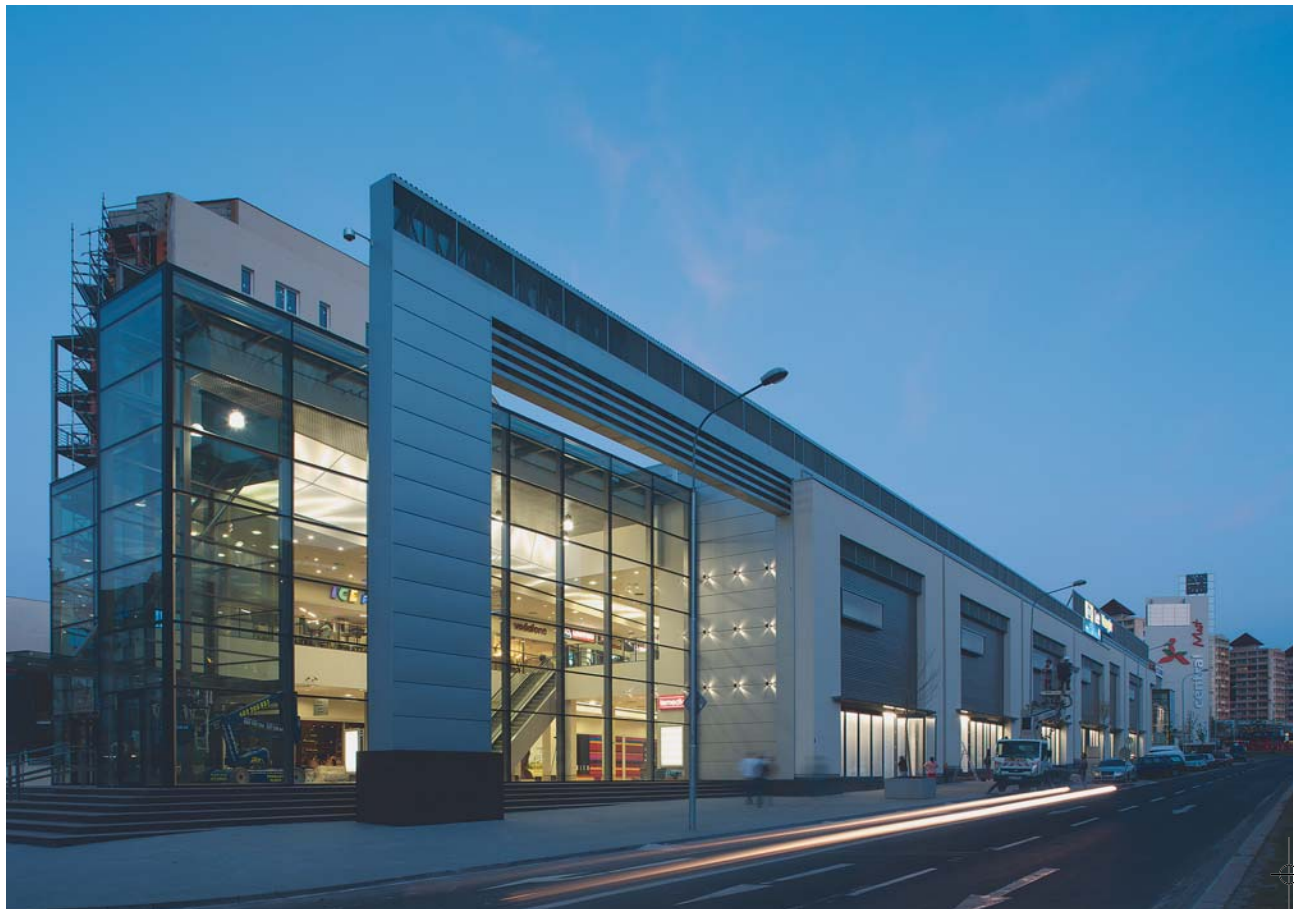
Kosmická osa se světélky poutá pozornost k objektu zejména za tmy.
