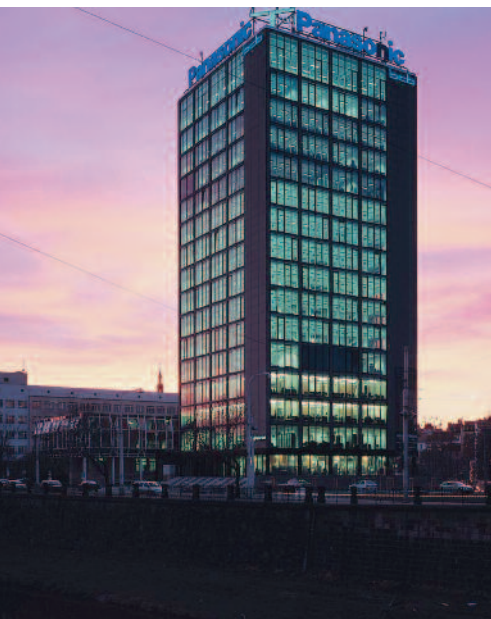
Severní pohled na budovu.
